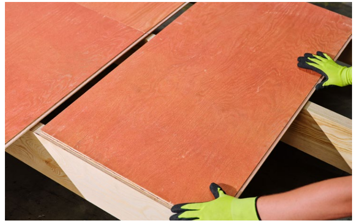
Rys. 7 Montaż płyt sklejkowych na konstrukcji dachu
